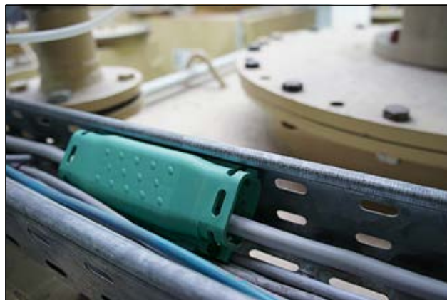
凝胶电缆接头 ReliPx V 用作电缆修复。
